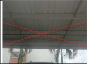
Riostas o tensor en X, ubicado entre algunas Alfardas en la estructura de parqueaderos dobles y sencillos, elaboradas con varilla metálica redonda de 13mm aproximadamente, longitud según su ubicación.
