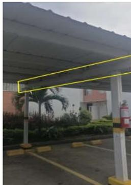
**LAS ALFARDAS** sirven de soporte a los perlines que soportan la estructura del techo del parqueadero, se encuentran sostenidas por las columnas y están elaboradas por dos perlines soldados entre sí.
