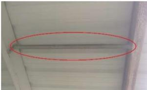
El tensor está elaborado en ángulo de 1", debe ser pintado en sus cuatro superficies, se encuentra ubicado entre los perlines que soportan de las tejas, tanto en la estructura doble como en la sencilla.
