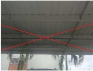
**Riostas o tensor en X**, ubicado entre algunas Alfardas en la estructura de parqueaderos dobles y sencillos, elaboradas con varilla metálica redonda de 13mm aproximadamente, longitud según su ubicación.
