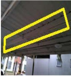
**Este perlinen "C"** sirve de soporte a las tejas de la cubierta de la estructura del parqueadero, ubicada sobre las alfardas, elaboradas por perlin sencillo, longitud según su ubicación.
