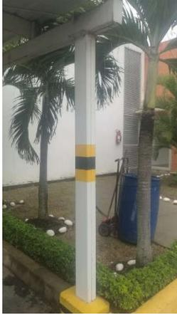
**COLUMNA TIPO CAJÓN**, da soporte de la estructura del techo, elaborada por dos perlines soldados entre sí, se debe incluir dos franjas de color amarillo y una franja de color negra como se muestra en la fotografía.
