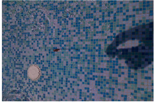
EN PISCINA DE NIÑOS PRESENTA FISURA EN PISO Y DESPRENDIMIENTO GEERAL DEL CRISTANAC
