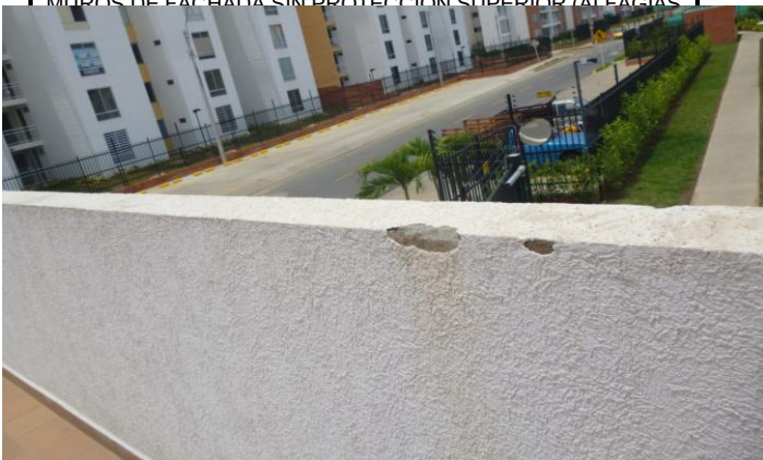
MUROS DE FACHADA SIN PROTECCION SUPERIOR (ALFAGÍAS)
